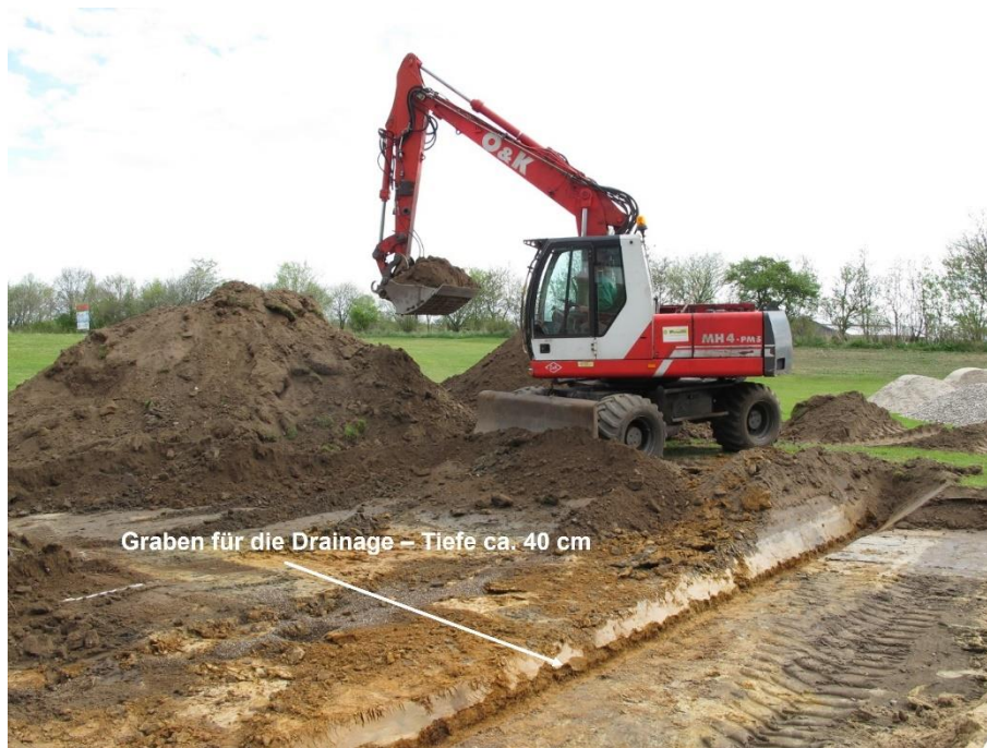
Bodenaushub mit einem Bagger
