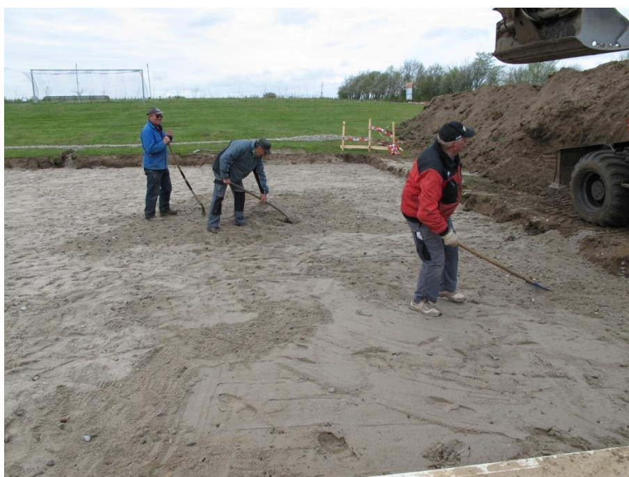
Frostschutzschicht – Schichtstärke ca. 8 - 12 cm – Material Kiessand Körnung 0/32 mm
