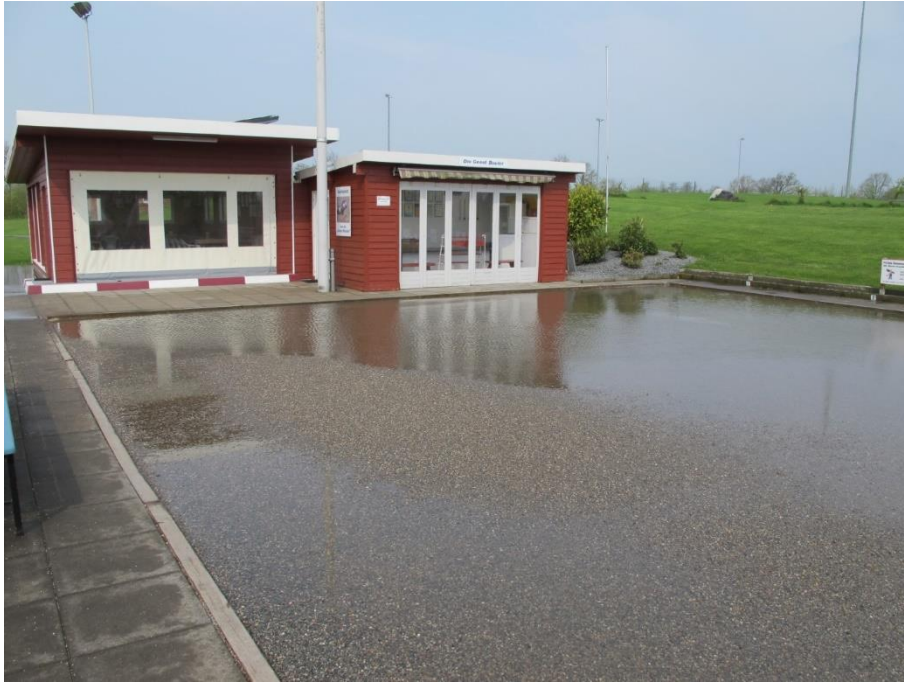
Bouleplatz nach einem Starkregen
