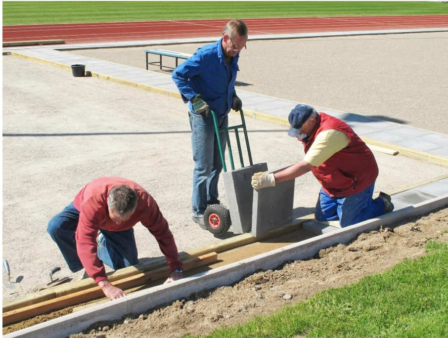
Pflasterung eines umlaufenden Gehweges
