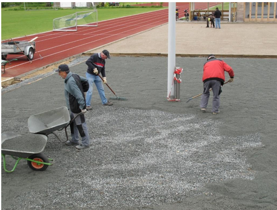
Ausgleichsschicht – Dicke ca. 4 cm – Material Granitsplitt Körnung 4/8 mm
