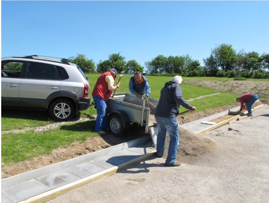
Verschleißschicht – Dicke 2 - 4 cm – Material Brechsand 0/3 mm
