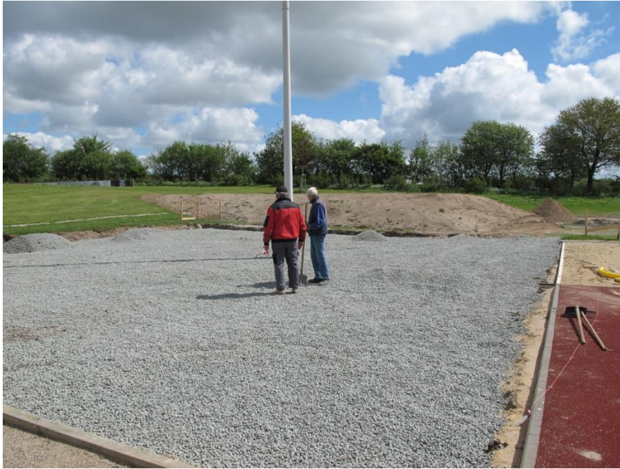
Tragschicht – Dicke ca. 6 cm – Material Granitsplitt Körnung 8/16 mm
