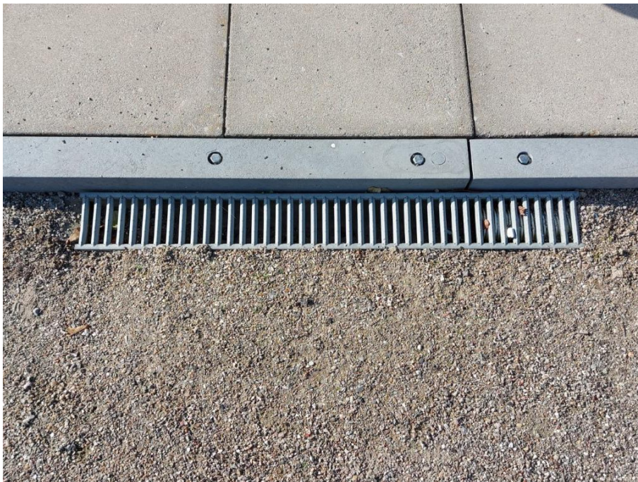
Wasserablauf auf einem Bouleplatz
